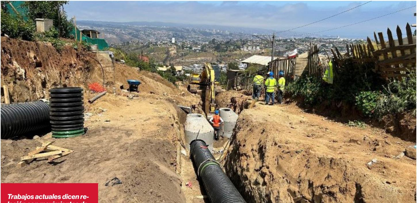
**Trabajos actuales dicen relación con movimientos de tierra para llegar a niveles de calzadas proyectada, excavaciones, colector de aguas lluvias, aceras con gradas y accesos vehiculares.**
