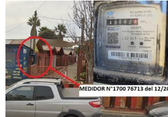
y no asegura la aislación de los conductores activos. Dicho remarcador de energía, al cual no hay acceso, alimenta instalaciones de un segundo local, ubicado en el borde costero conconino. Además, se estableció que los conductores vuelven a pasar por encima del techo de diversos locales, hasta llegar al último punto.
