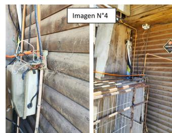
el alimentador llega a un tablero de distribución para instalación interior, el cual **está situado afuera de uno de los locales en una caja plástica**, situación que no cumple la norma para su instalación.
