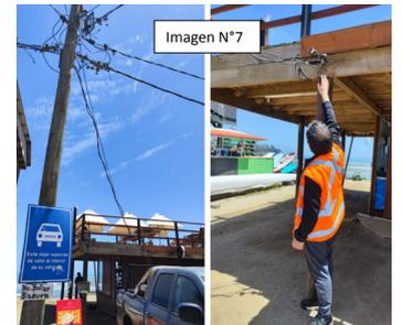
de protección y servicio, y falta de cajas conexión, con derivaciones y conexiones al alcance de la mano.
